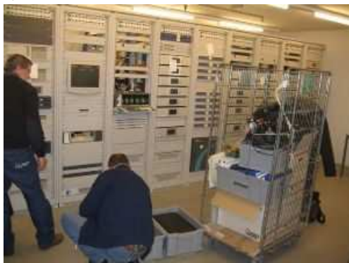
Demontage MPEG compressie apparatuur
